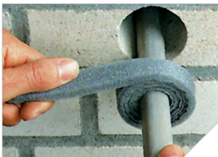
1. Montér bagstop på rør/kabel.
